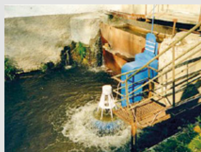
Malá vodní turbína pro velmi malé spády a průtoky (Ing. Miroslav Štěrba – MIRIS / Foto: Jiří Spousta)
