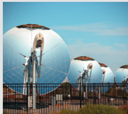
Parabolické zrcadlo sleduje pohyb Slunce a koncentruje jeho záření do ohniska, kde je Stirlingův motor, který vyrábí elektřinu, chlazením motoru lze získávat teplo
