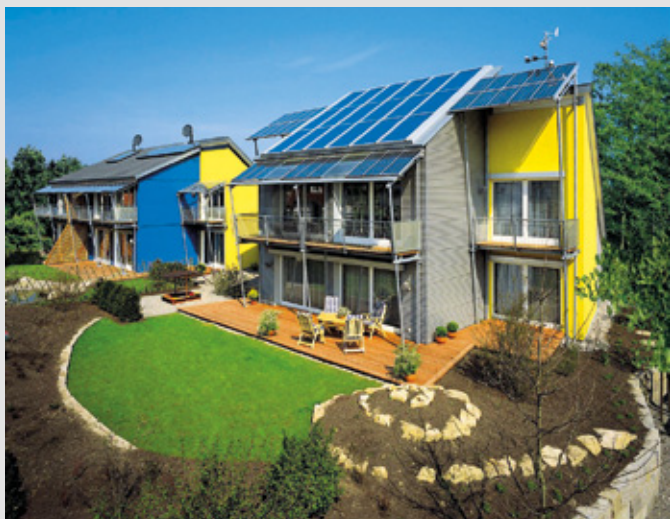
Solární fotovoltaické i fototermitické panely integrované do střechy (Rolf Disch SolarArchitektur)
