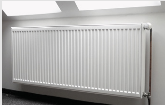
Ocelový radiátor využitelný pro teplotní spád cca 50/40 °C. Nízkoteplotní ocelové radiátory jsou velmi podobné vysokoteplotním, jen musí mít větší plochu (Vendula Zemková)
