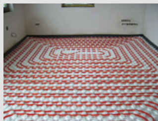
Pro ještě nižší teploty (35/25 °C) nelze použít radiátory (jejich plocha by byla příliš velká) a místo nich se využívá podlahové nebo stěnové vytápění (ROKOV Technology s.r.o.)
